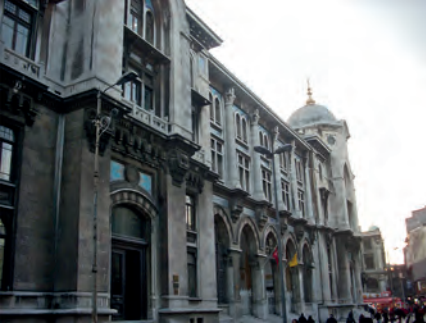
1905-1909 yıllarında Mimar Vedat Tek tarafından yapılan, Sirkeci Büyük Postane Binası İstanbul.
